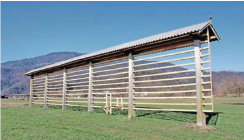
Obnovljen Milharjev kozolec
